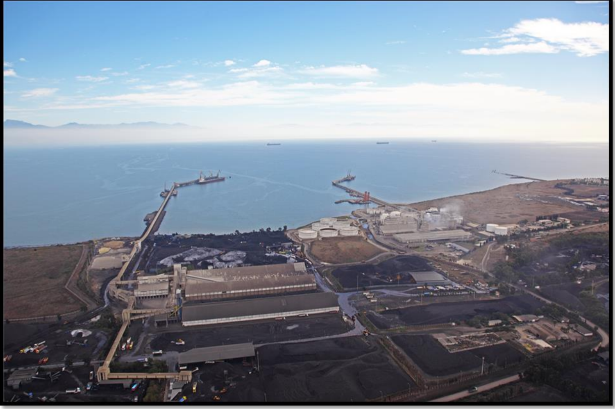
EK-2: Ceyhan Liman Tesisi Genel Görünüş Fotoğrafi
