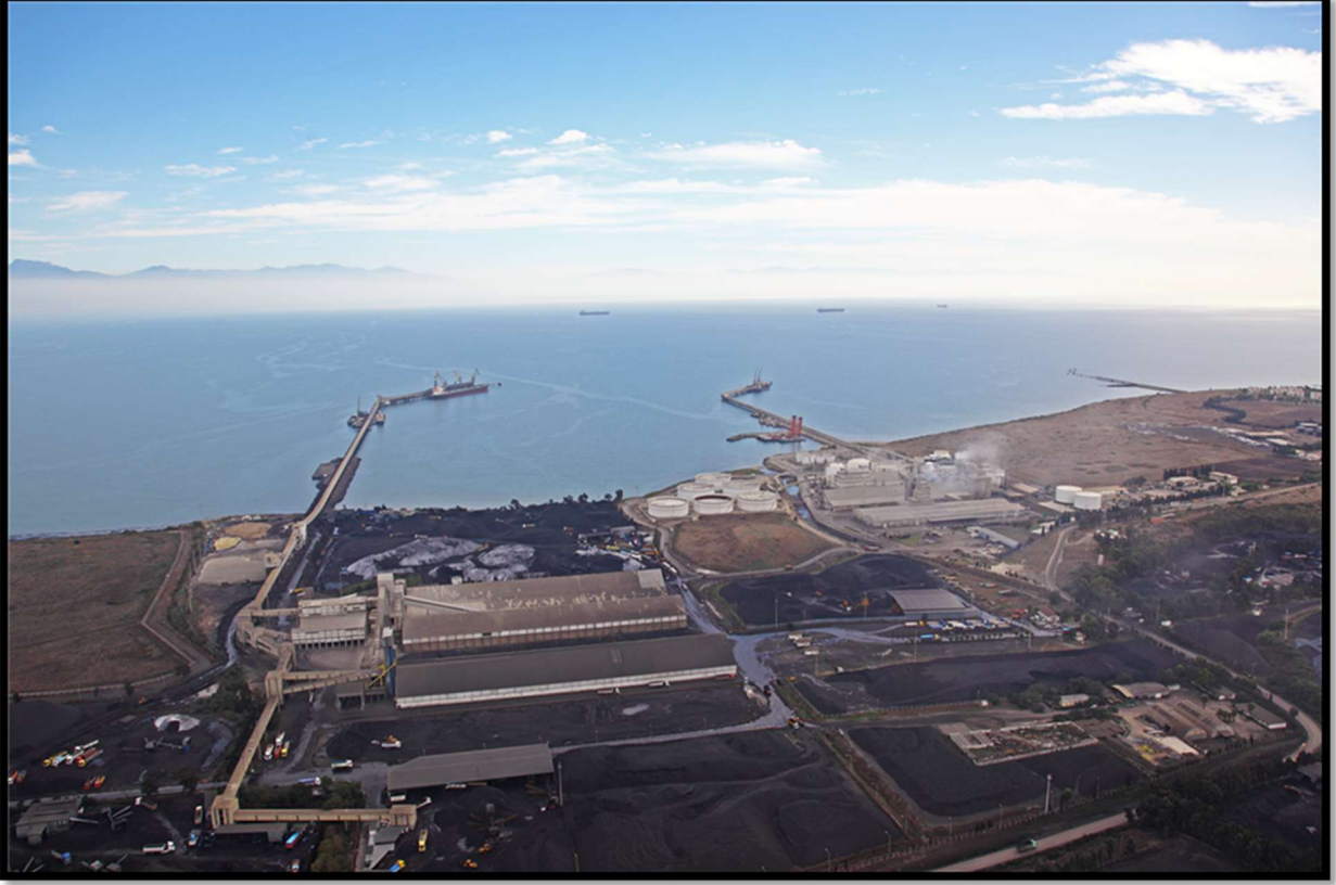
EK-2: Ceyhan Liman Tesisi Genel Görünüş Fotoğrafi
